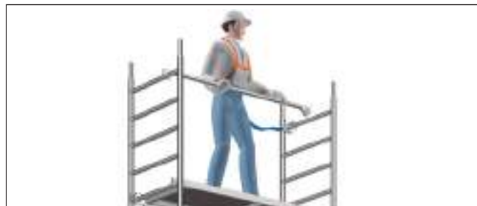
Fig. 3: Colocación de las barandillas con EPI
