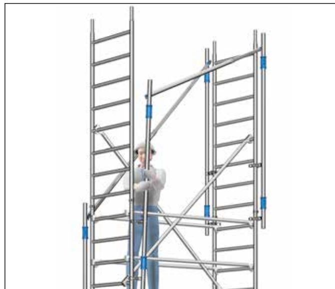
Fig. 5: Moviendo el AGS hacia arriba
