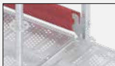
Montaje de rodapié de madera.
